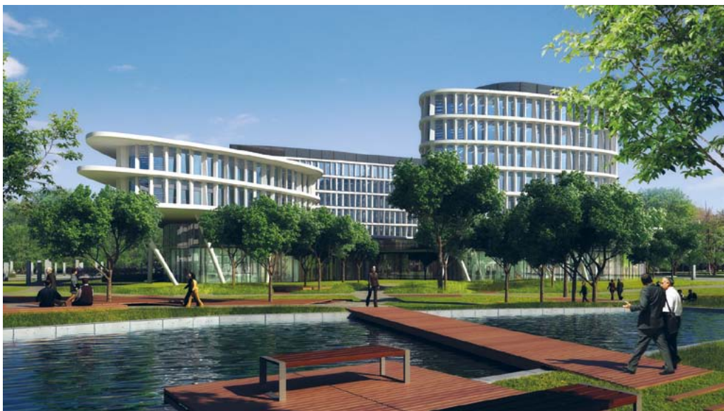
Pierwsza faza projektu Business Garden Warszawa zostanie oddana do użytku we wrześniu 2012 roku.
